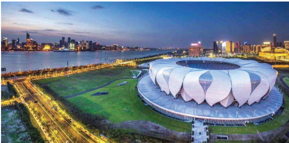
▲莲花造型的杭州奥体中心主体育场,2022年杭州亚运会开闭幕式将在这里举行。
