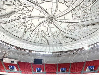
小莲花的屋顶，能360°无缝旋转。
