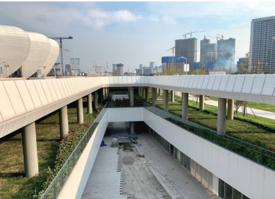
施工中的商业街
