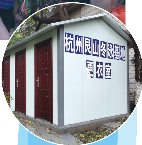
▲泳池旁新修建的更衣室
