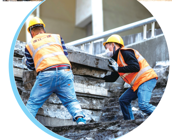
工人们铆足了劲抢时间赶工期,确保改造项目如期完成。
