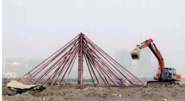
2010年3月，试打桩进行试压。
